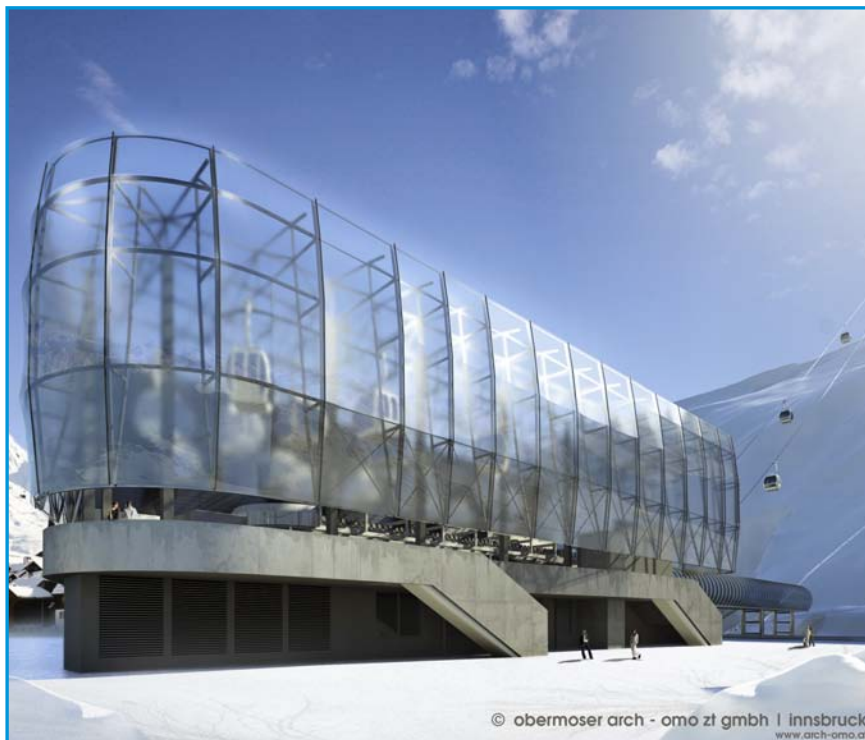
Hell, leicht und beständig: die neue Talstation der Gaislachkogelbahn. Fertigstellung Ende 2010.
