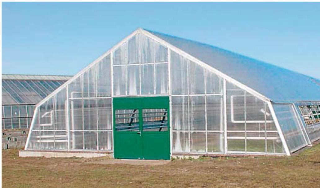
Ein mit Doppelfolie eingedecktes Gewächshaus, bei dem zuvor die Glaseindeckung demontiert wurde
