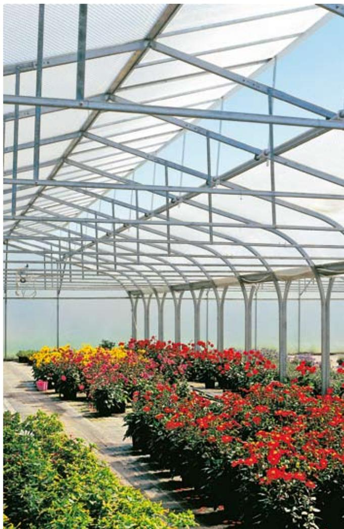
Luftpolsterfolienhaus vom Typ 10 × 100 m mit zwei vollautomatischen Seitenlüftungen (Firma Krötz)
