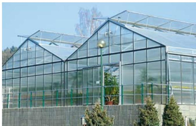
Foliengewächshaus mit durchgehender Dachlüftung (Firma Götsch & Fälschle)
